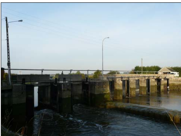
Portes à flots de la Barquette sur la Douve, à Carentan
