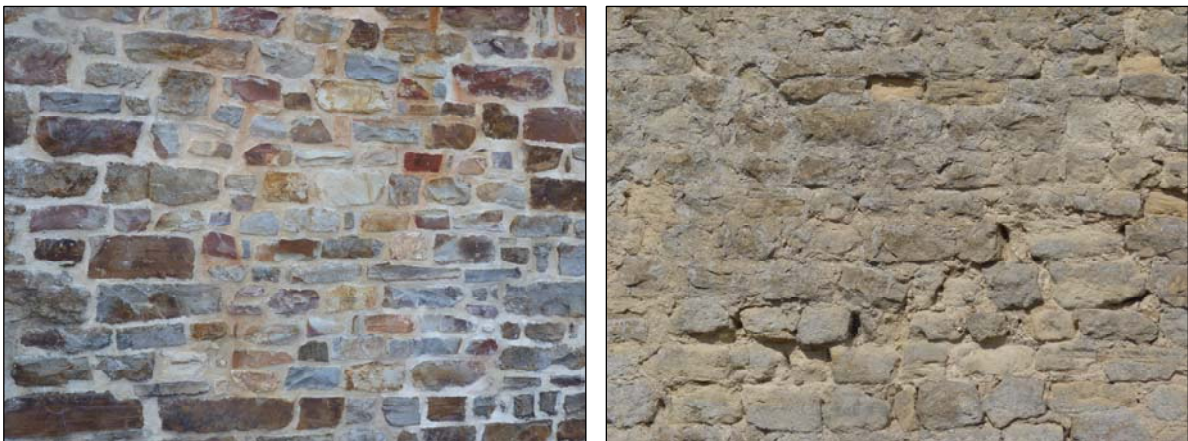
Illustration des matériaux employés dans les constructions : grès de carrière et pierre calcaire
