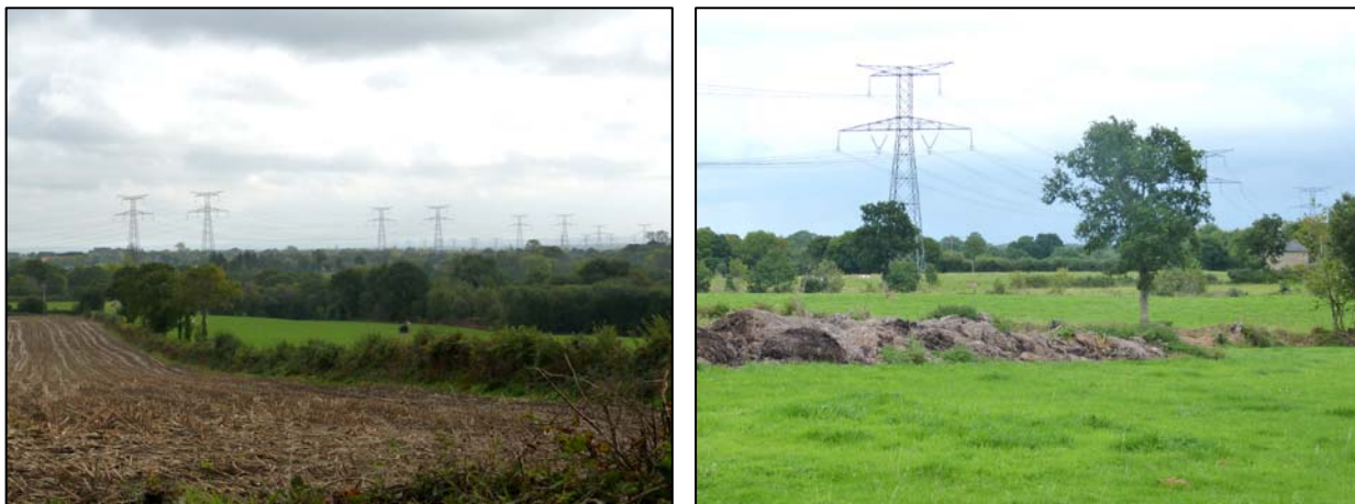
Exemples de ligne 400 KV
