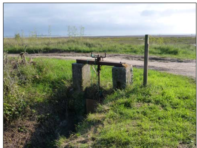
Vanne sur un petit cours d'eau littoral, sur la commune d'Aumeville-Lestre
