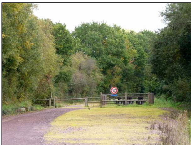
Voie verte à Lithaire, sur l'ancienne voie ferrée
