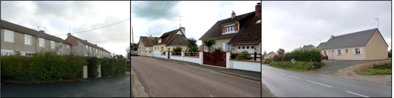
Les constructions contemporaines sont majoritairement des pavillons, implantés au centre des parcelles. De gauche à droite : habitations collées des années 60-70 à St-Jean-de-Daye, lotissement des années 70-80 en entrée de bourg de La Cambe, groupe de pavillons récents en entrée de bourg de St-Sébastien-de-Raids
