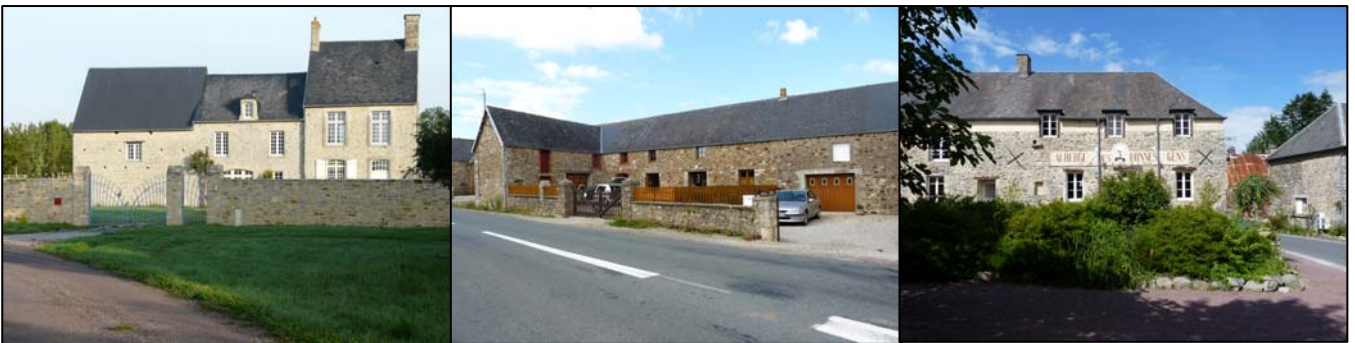
Exemples de bâtisses traditionnelles en pierre (pierre calcaire à gauche et non calcaire au centre et à droite)
