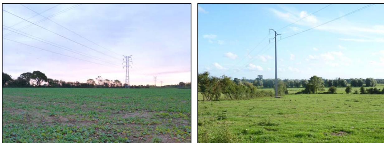
Exemples de ligne 90 KV
